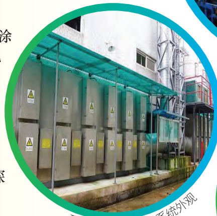
皮革喷涂VOC废气源(左)及生物滤床系统(槽缸)
